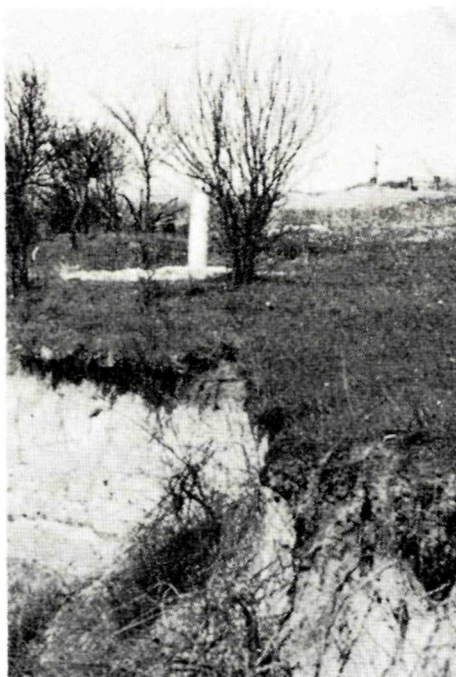
Foto 4. Pozorovaný bod na okraji aktívneho zosuvu Photo 4. Observed point at the margin of an active landslide
