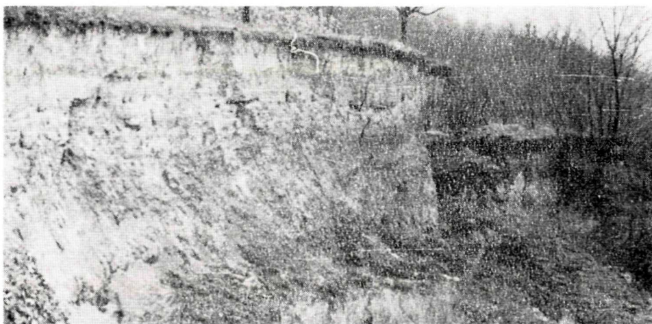
Foto 2. Odlučné hrany aktívnych zosuvov pri Šintave Photo 2. Steplike scar edges of active landslides near Šintava
